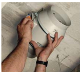
Colocar o corpo motor
