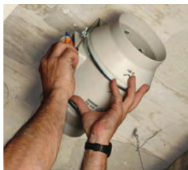
Colocar o corpo motor
